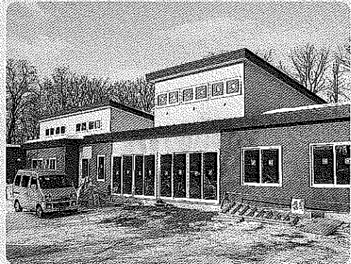
建築中の共生型施設(奥が「ふたば」)
